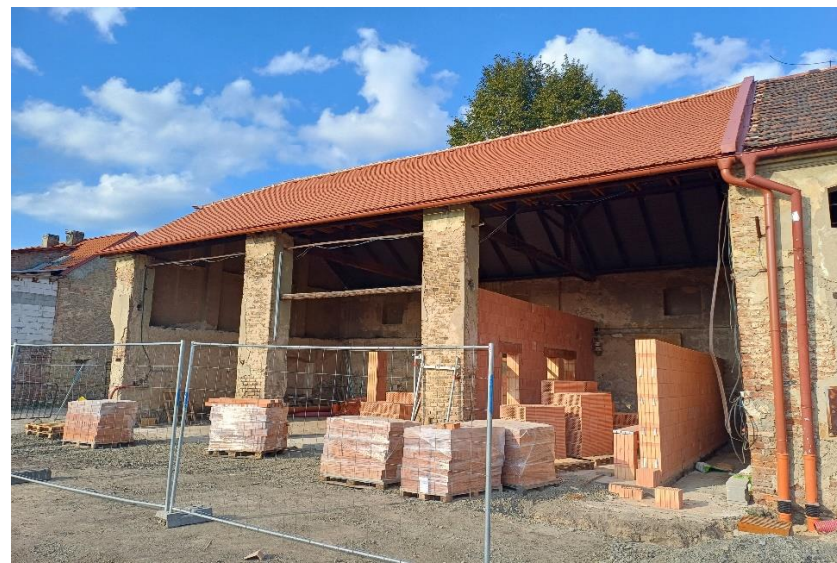
Modernizace hasičárny v Lukavci, září 2024
